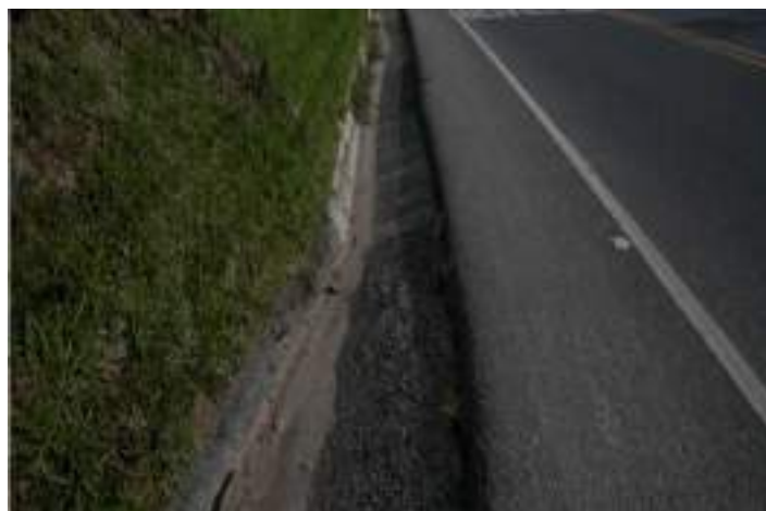
Descripción: desnivel entre la calzada y la berma / cuneta
