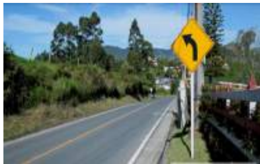
Descripción: señalización vertical en buen estado, previo a una curva
