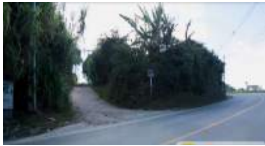
Descripción: sobre la vía existen ingresos a predios, veredas sin señalizar
