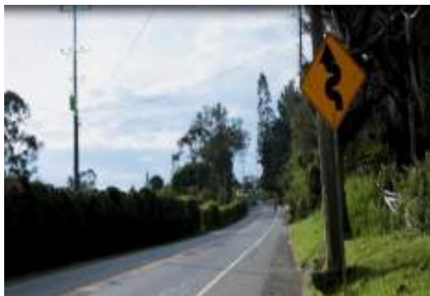
Descripción: señalización en buen estado
