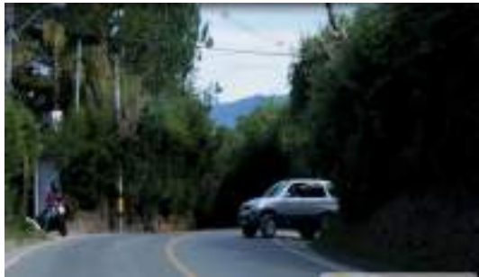
Descripción: sobre la vía existen ingresos a predios, veredas sin señalizar
