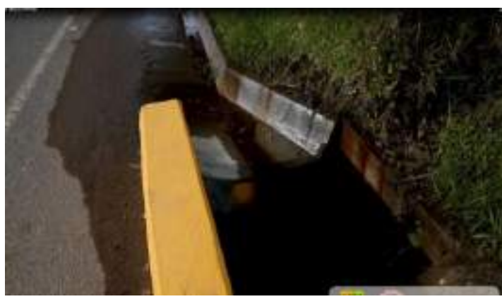
Descripción: estas cunetas solo cuentan con pintura amarilla, pero es peligroso para los ciclistas, motociclistas y peatones que caminan por la vía
