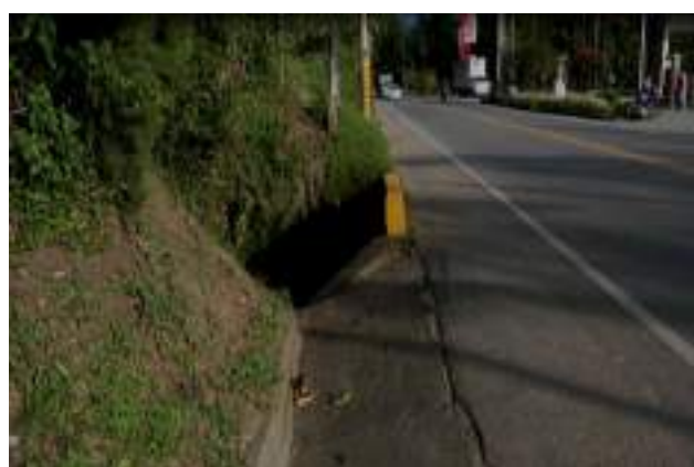
Descripción: cunetas para drenaje de la vía
