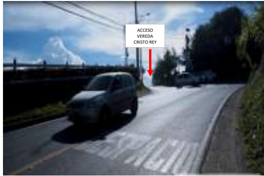
Descripción: el acceso a la vereda Cristo Rey no tiene señalización previa
