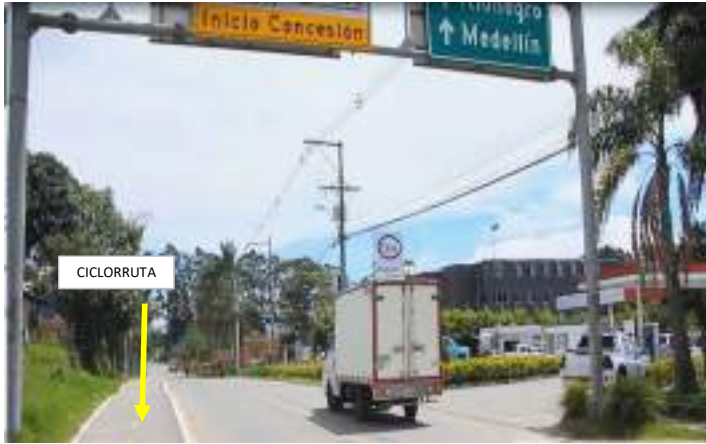
Descripción: la demarcación de la vía se encuentra en buen estado, hacen falta pictogramas
