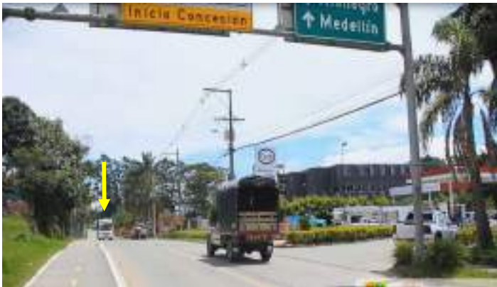
Descripción: en el punto no existen paraderos, lo que lleva a que el transporte público haga paradas donde lo solicite el usuario, esto produce adelantamiento
